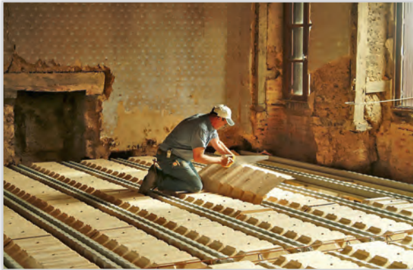
Systemy stropowe RECTOBETON i RECTOLIGHT. Stosowane przy renowacjach. Wymiana stropu charakteryzuje się: łatwością i szybkością montażu, lekkością konstrukcji stropowej – ciężar od 187 kg/m 2 , możliwy montaż bezpodporowy – nawet do 5,8 m, możliwość wykonania wieńca na pierwszym rzędzie pustaków, oparcie belek w gniazdach w ścianach.
